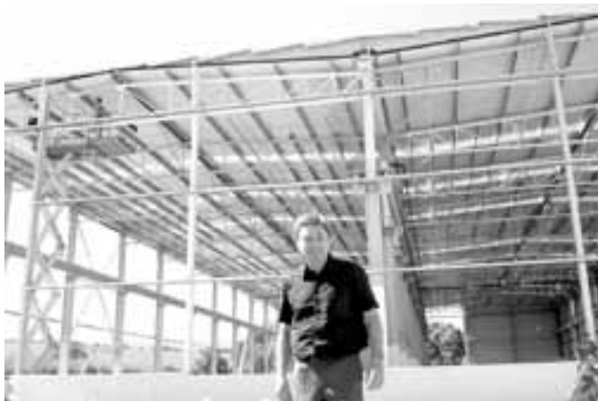
To je snímek z loňského léta, manažer Michal Pospíšil před rozestavěnou halou. FOTO: ZL
